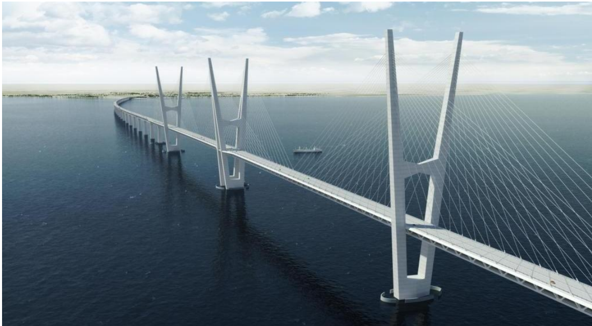
Perspektiv af en højbro over Femern Bælt med to frie spænd på hver 724 m.
